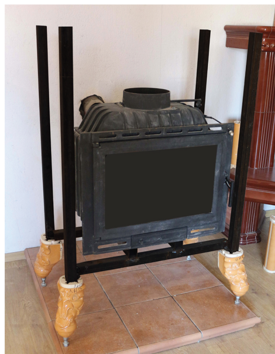
5. После монтажа ног устанавливается топка.
