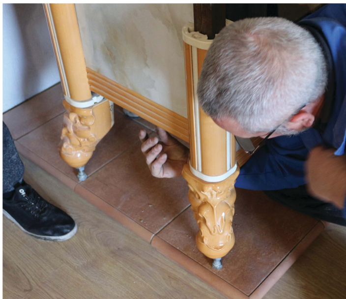
7. Устанавливаются по периметру все нижние плиты в пазы, с упором на металлические пластинки.
