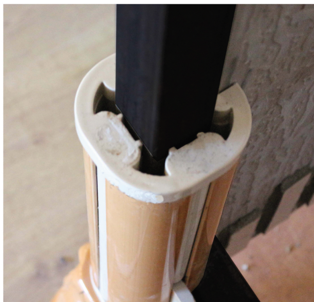
6.Устанавливаются 1й ряд трубчатых ног с шайбами пазами по направлению к плитам.
