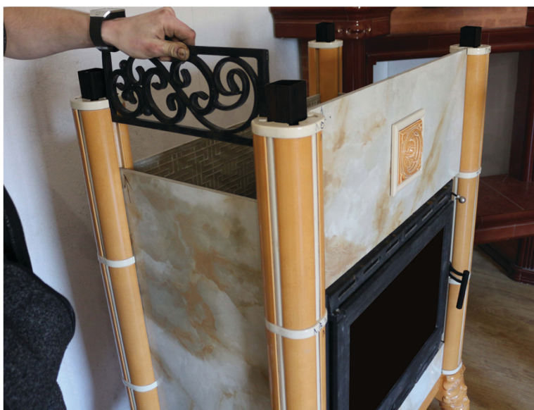
10. Установка вентиляционной решетки
