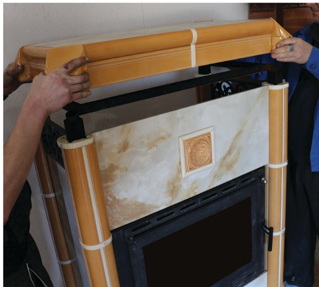
12. Устанавливаем керамогранитную крышу.
