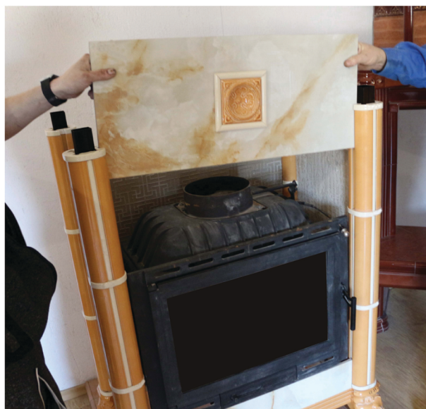
9. Установка верхней фасадной плиты (топка выставляется в одной плоскости с фасадными плитами)
