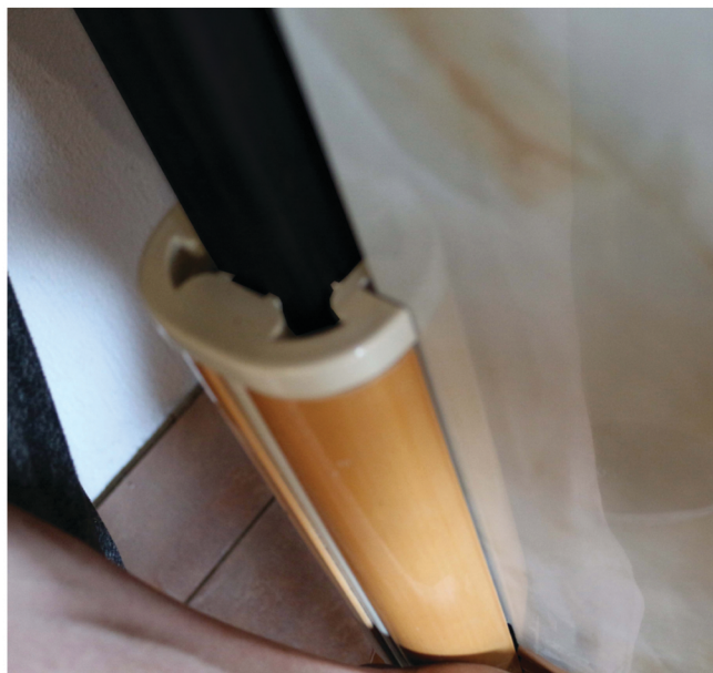
8. Устанавливаются по периметру все нижние плиты в пазы, с упором на металлические пластинки.
